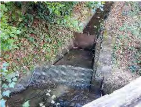
Figure 2: grilles installées sur le canal au niveau de la prise d'eau du ravin de la Bastide
